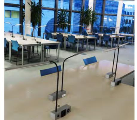
Sonderanfertigung der Schreibtischleuchten mit beweglichem Leuchtarm und Konsole inklusive USB-Stecker, Ein/Ausschalter und Steckdose. LED Licht 7 Watt mit 4000 Kelvin. Oberflächenlackierung DB702.
