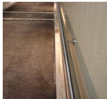
Langstreckenleuchte für Innen- und Außenflächenbeleuchtung mit Leuchtstoffröhren. Das Lichtgehäuse besteht aus eloxiertem Aluminium. Die Position der Reflektoren erlaubt es 100% der Lichtausgangsleistung des Rohres auf eine ebene Fläche zu reflektieren. Gleichzeitig dienen die fest montierten Rohre als Handlaufleiste.
